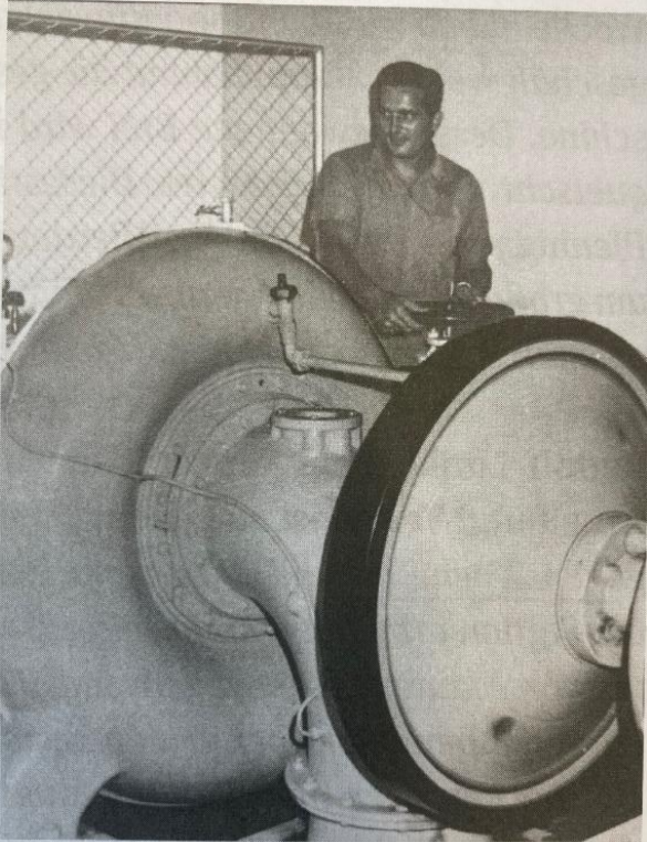
Das Kernstück des neuen Kraftwerks: eine guterhaltene, alte Turbine.
